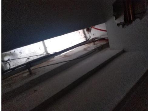
**NOTA:** Para dar solución al escurrimiento del agua se propone modificar la carpintería existente "in situ", retirando el actual policarbonato y limpiando la superficie de restos de pegamento o suciedad, luego la fabricación con un perfil I de un bastidor como soporte del nuevo vidrio. Colocar vidrio mayado por sobre el nivel del mármol y permitir el buen escurrimiento del agua sellando todas las uniones con silicona.
