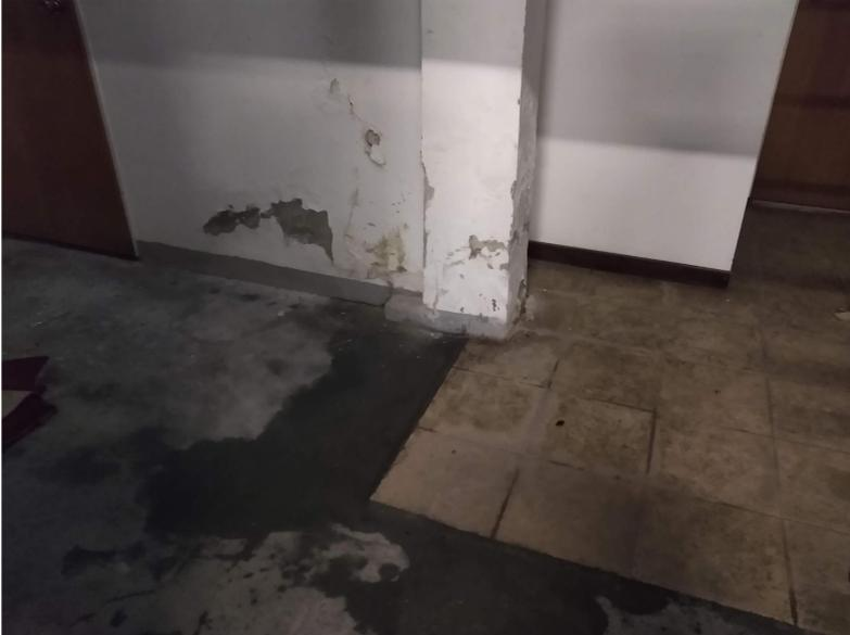
NOTA: Se solicita la reparación del recubrimiento del pilar en conjunto con el revoque existente del muro de mampostería, aplicando revoque nuevo en el área afectada por la humedad.
