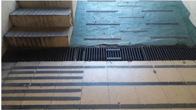
NOTA: Para impermeabilizar la canaleta de desagüe de la rampa se procederá con el mismo procedimiento mencionado en el punto 4 (CANTEROS). Luego de la limpieza del área se repara las fisuras existentes y aplicará un revoque con la aislación correspondiente, eliminando las aristas del cajón y aplicando las 7 capas de fieltro con pintura asfáltica.
